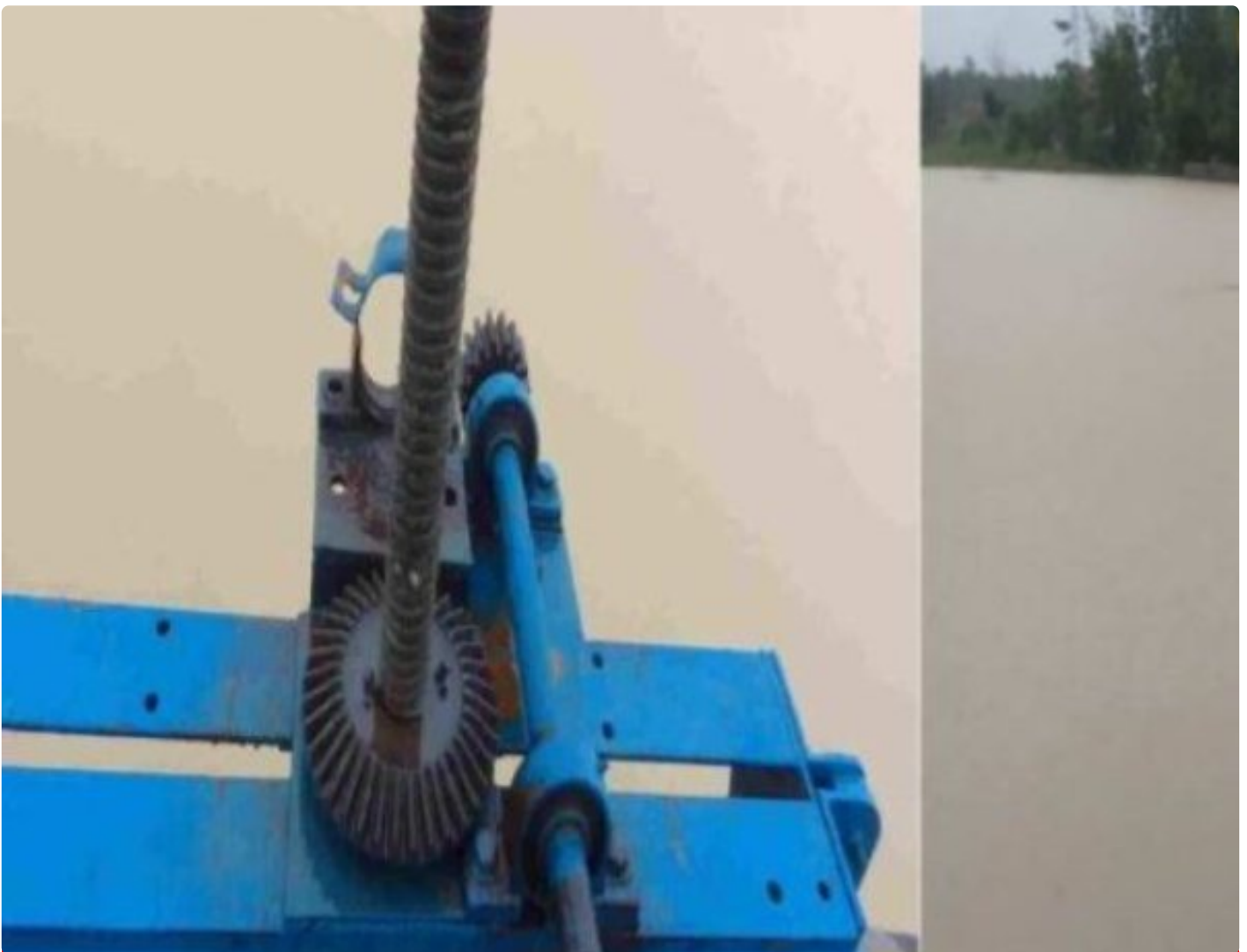
Pintu air Albaret Simpang Mesuji
